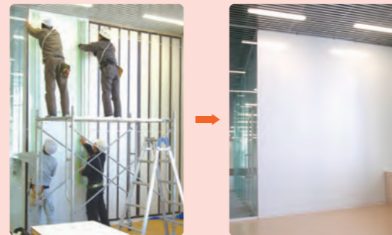
壁全体施工例：高い壁の全面に施工
